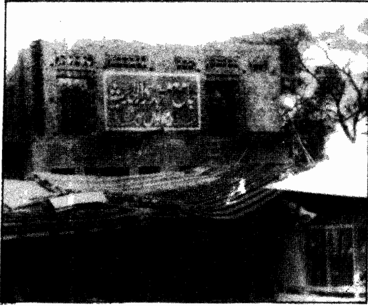
زیر تعمیر مسجد دارالحديث راجو وال (بیسرونی منظر) شمالی جانب
